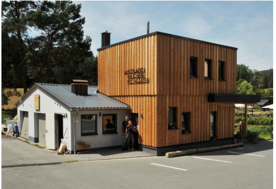
Der mit Lärchenholz verkleidete Neubau, der an die Hälterung und die Räucherei grenzt, bildet mit dem Hofladen und der Teichterrasse das Zentrum des Betriebes.
